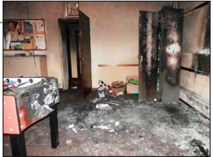
La sala parrocchiale devastata dall'incendio
